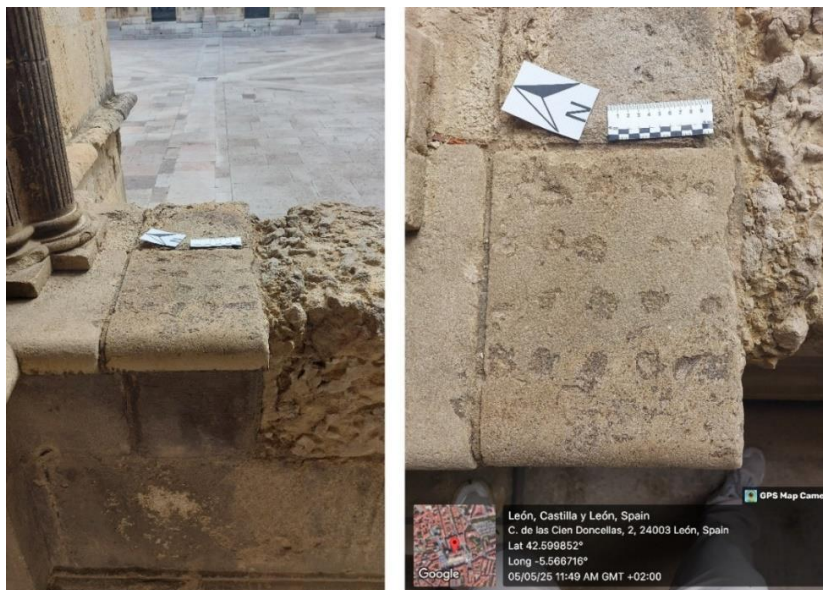
Fig. 3. Tablero nº 2 situado en la balaustrada oeste del claustro. Fotografías de la autora.
