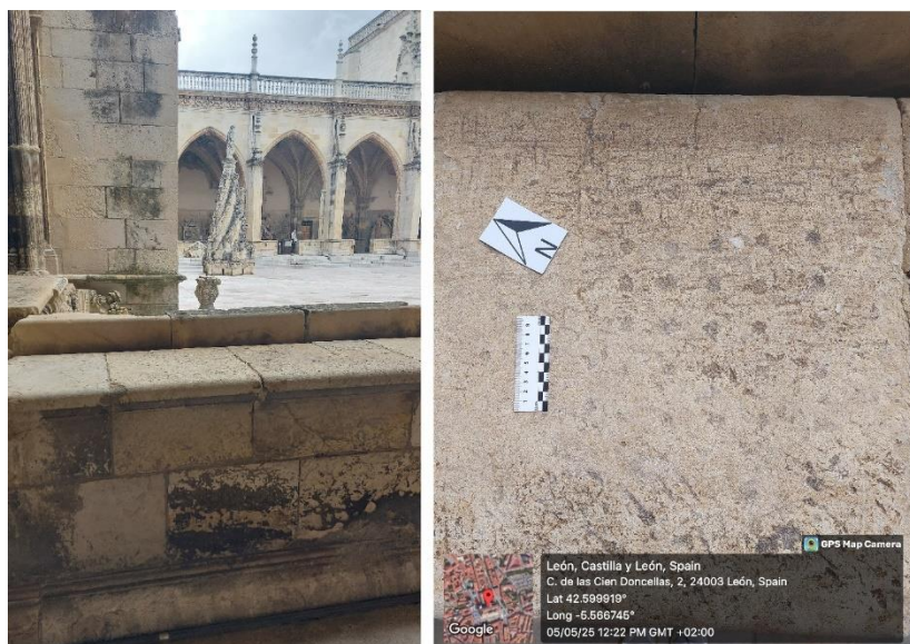
Fig. 7. Tablero nº 6 situado en la balastrada oeste del claustro. Fotografías de la autora.
