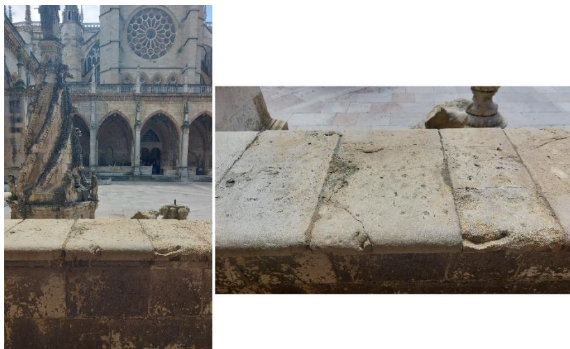
Fig. 8. Visión general de los tableros nº 7, 8 y 9 situados en la balaustrada norte del claustro. Fotografías de la autora.
