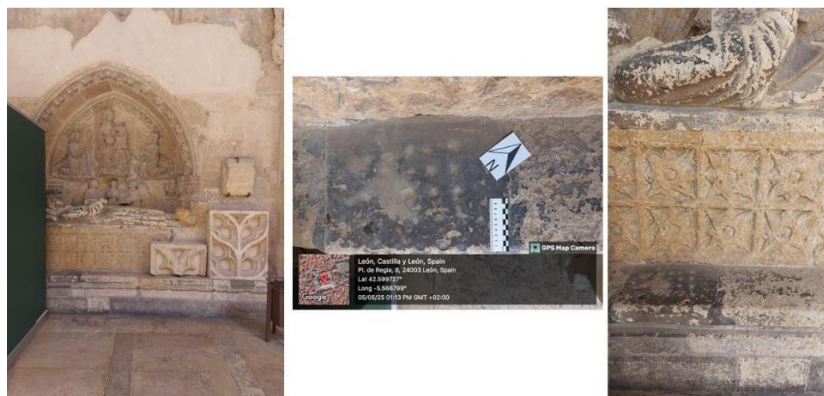
Fig. 11. Tablero nº 10 situado en la galería norte del claustro. Fotografías de la autora.
